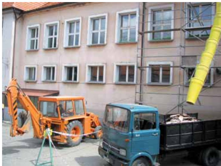
Na boisku szkolnym zagościł sprzęt budowlany
