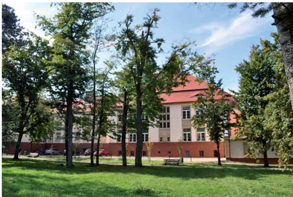
Nowe elewacje gruntu remontowanej SP 4
