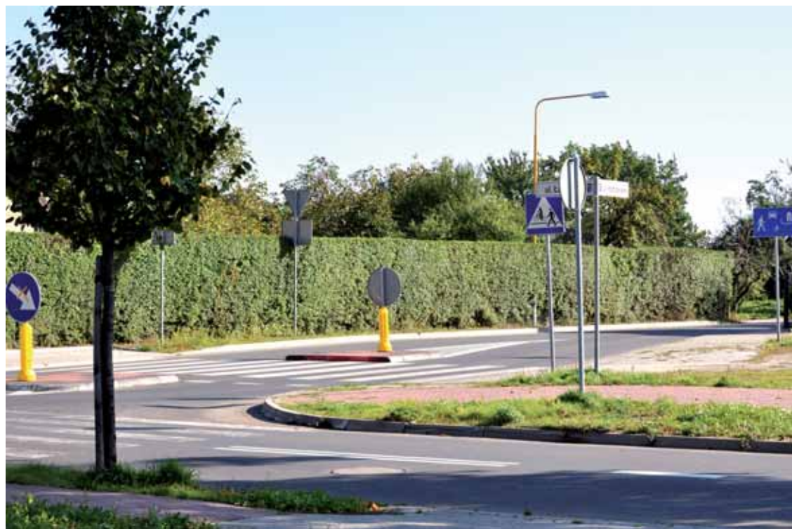
Skrzyżowanie ulicy Łąkowej z Karbowiaka po modernizacji
